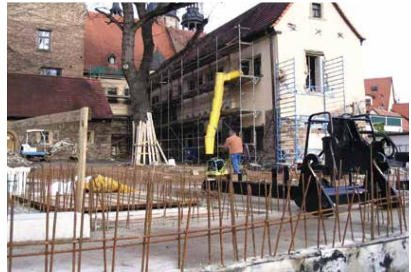
Bauarbeiten an Luthers Sterbehaus. Foto: Stiftung Luthergedenkstätten Sachsen-Anhalt
