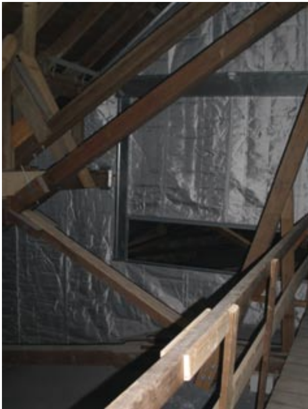
Feuerschutzvorhang zur Unterteilung des Dachraumes (Dom zu Speyer)
